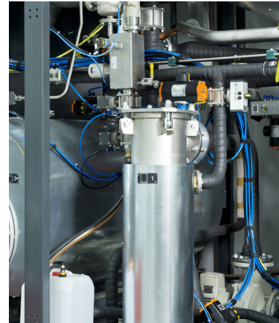
Contrôle et séchage des filtres
